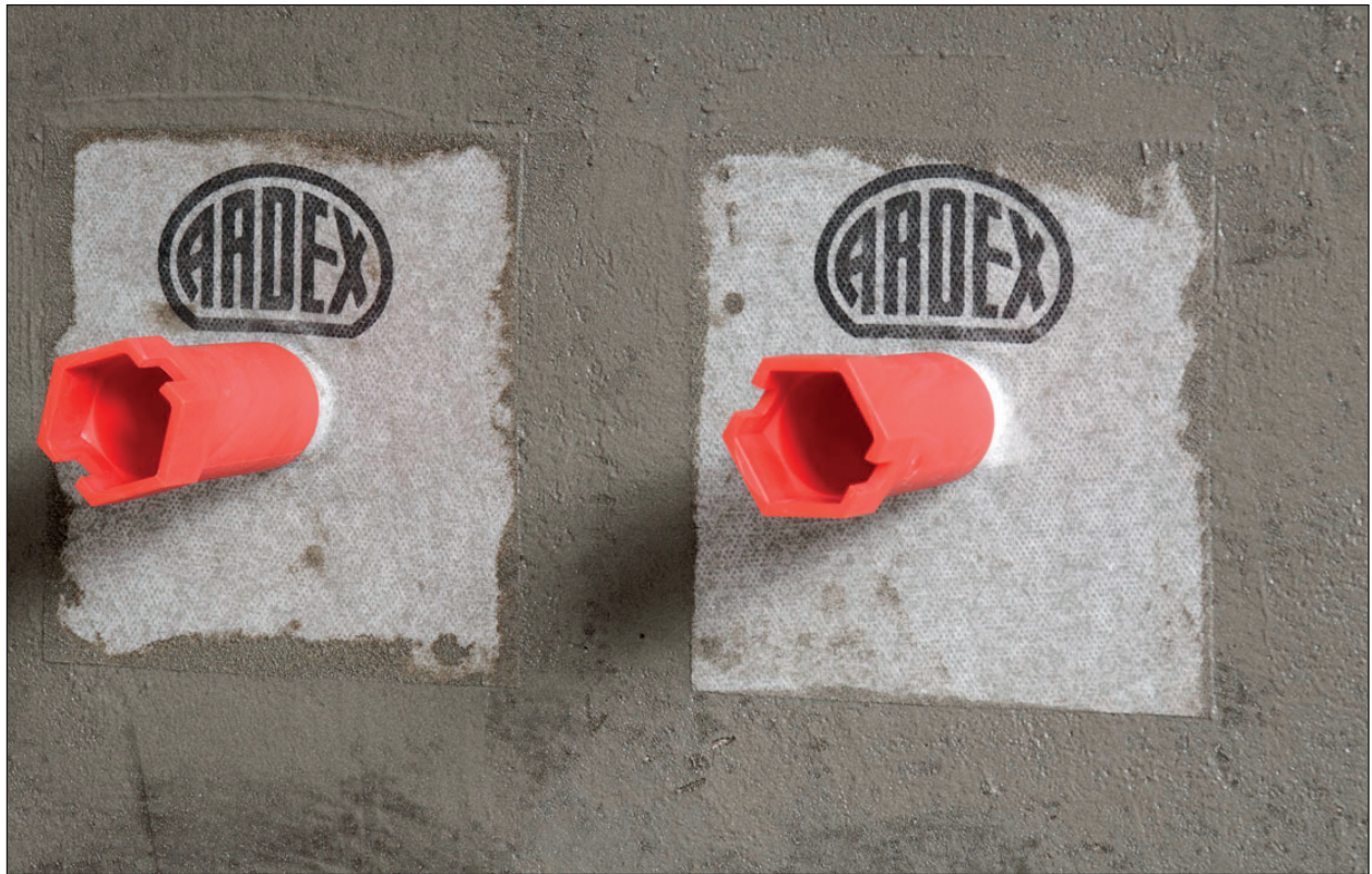
Bild 11: Einarbeiten der Dichtmanschetten (Bild: ARDEX)
